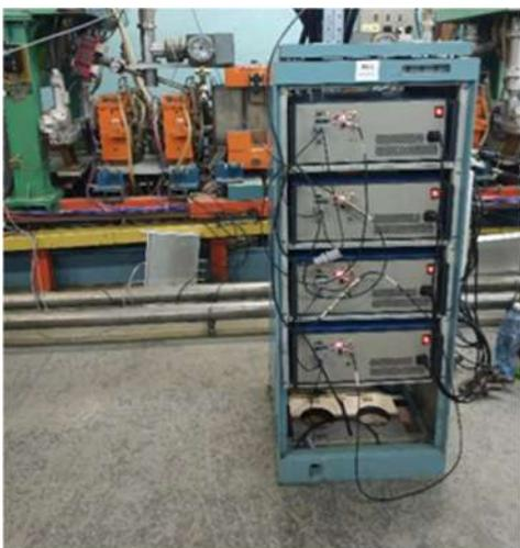
Рисунок 14. Стойки высоковольтных источников питания инфлекторов в зале накопителя-охладителя комплекса ВЭПП-5.
