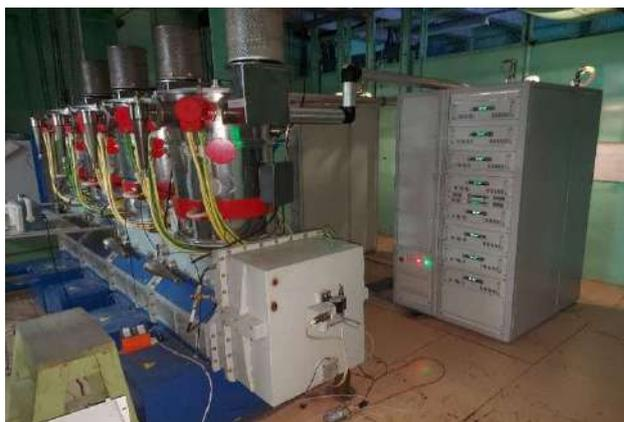
Рисунок 2. Новые предусилители (два шкафа) расположены на месте старого и соединены с тетрами выходного каскада четырьмя коаксиальными волноводами.
