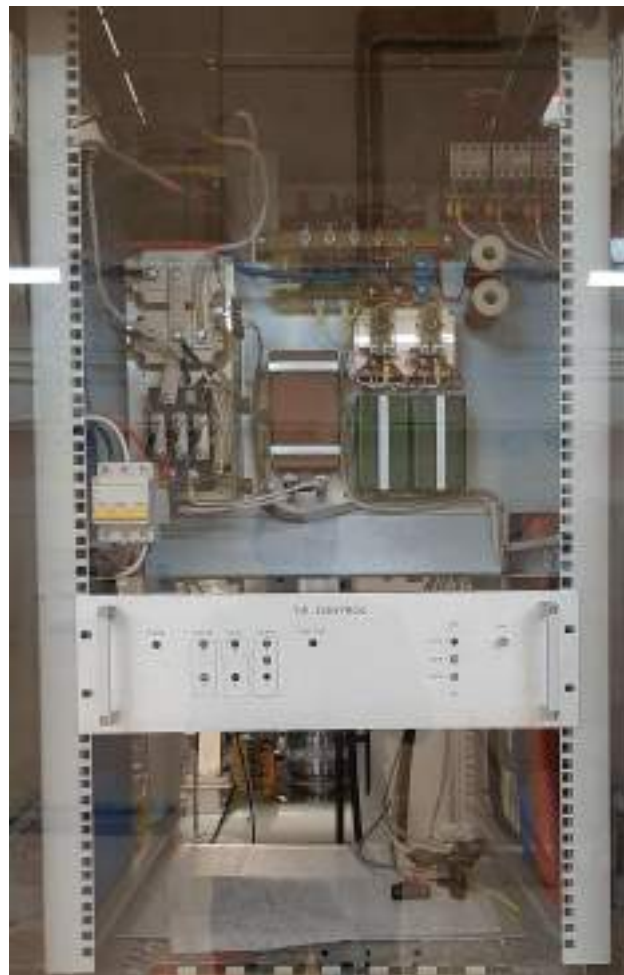
Рисунок 8. Система питания титановых испарителей.
