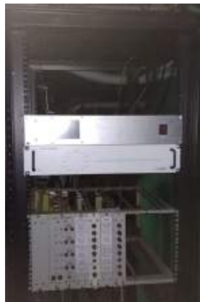
Рисунок 9. Блок управления с сенсорным экраном и блок электроники датчика тока.
