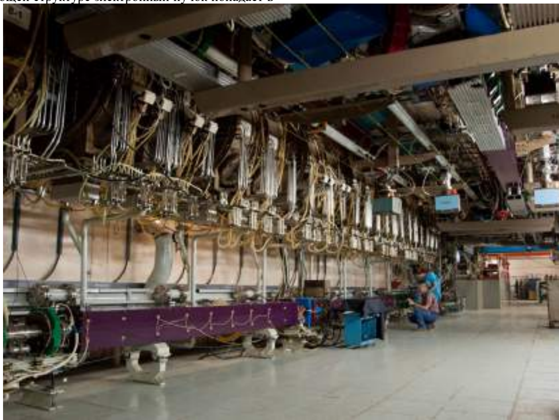
Рисунок 3. Новосибирский ЛСЭ в ускорительном зале.
