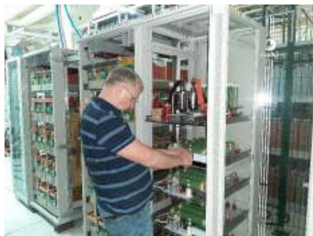
Рисунок 5. Система питания генератора плазмы.
