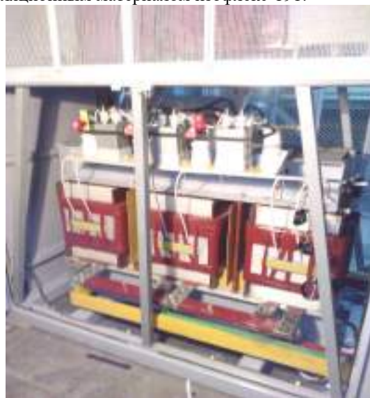
Рисунок 10. Внешний вид трансформатора заводского исполнения.
