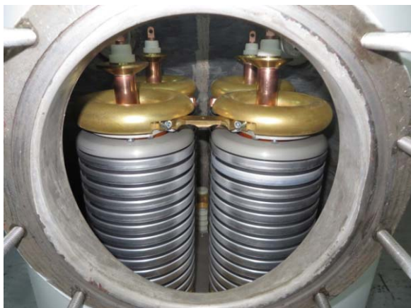
Рис. 7.3.1. Разделительный трансформатор в баке. Вид через окно вывода мощности.
