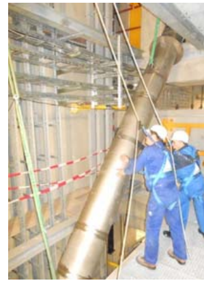
Рис. 5.10.6. Установка трубопровода в шахту здания XFEL.
