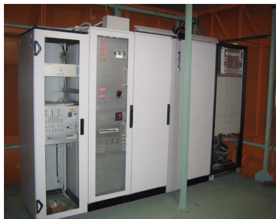
Рис. 7.3.2. ВЧ система второго стенда на платформе 880 кВ.
