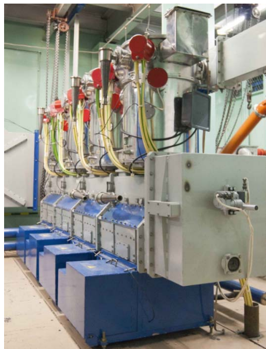
Рис. 7.6.1. Выходной четырёхмодульный каскад генератора с установленными устройствами подавления самовозбуждений.
