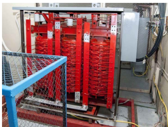
Рис. 7.6.2. Трансформатор и диодный мост (справа) вольтодобавки анодного напряжения.
