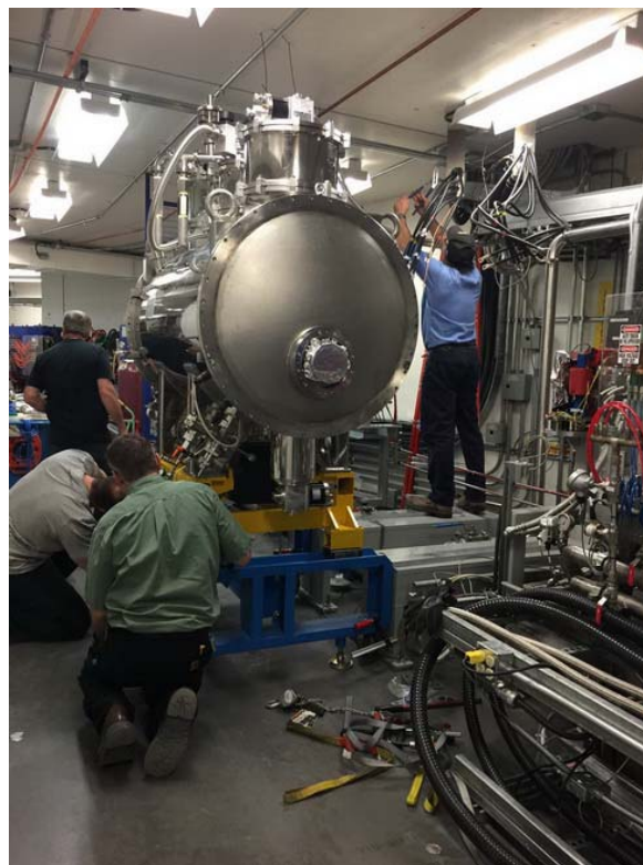
Рис. 6.5.2. Установка модернизированного 27-полюсного вигглера BMIT с полем 4 Тл на накопителе CLS (Канада).
