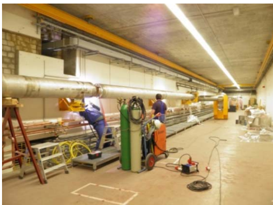
Рис. 5.10.5. Монтаж криогенного оборудования в зале инжектора 1.
