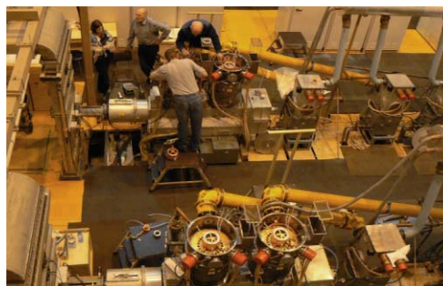
Рис. 7.9.1 Панорама генераторного зала комплекса «Сибирь-2» в процессе замены ламп.
