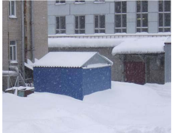
Рис. 5.1.2. Домик над заходной шахтой канала К-500.
