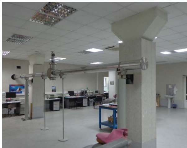
Рис. 6.4.6. Горизонтальный распределительный канал в зале, предназначенном для новых пользовательских станций.
