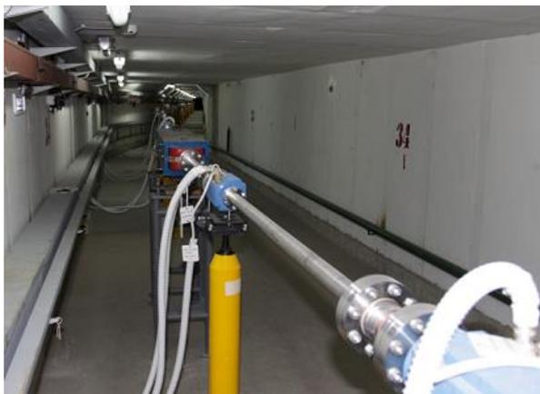
Рис.4.10. Фотография части канала К-500 с импульсными магнитами.
