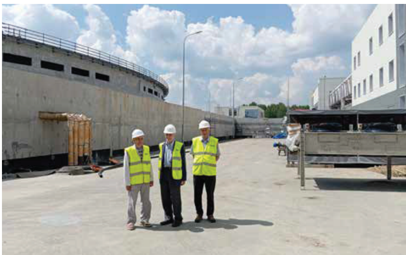
Участники экскурсии на фоне строящегося комплекса.
