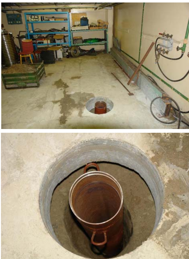
Рис. 10. Фотографии этапа монтажа заглубленного защитного контейнера для выдержки и временного хранения активированных мишеней.
